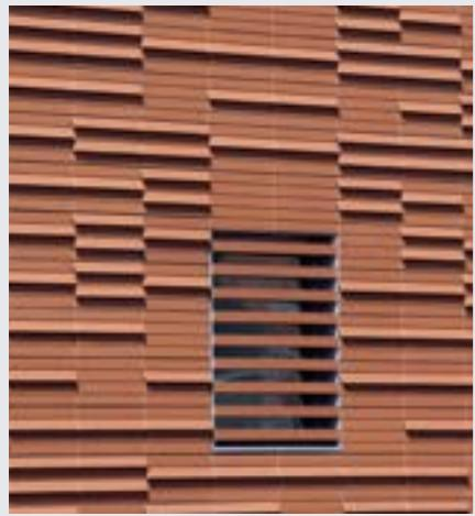
NBK ha sido pionera en la fabricación y diseño de fachadas ventiladas de terracota cerámica de gran formato. La arcilla, con la cual se fabrican los paneles cerámicos, es un material natural que provee calidez y durabilidad, y ha sido requerido durante siglos en las edificaciones de todo el mundo.
